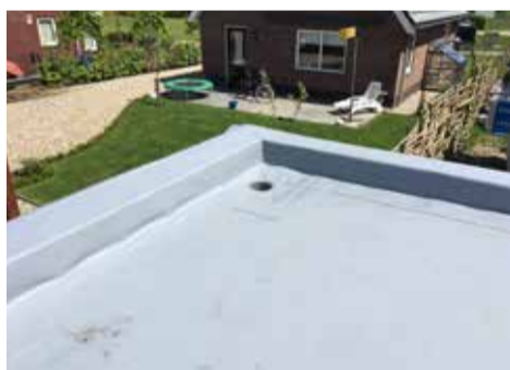
Fixatie detail resulteert in vakkundig en strakke uitvoering
