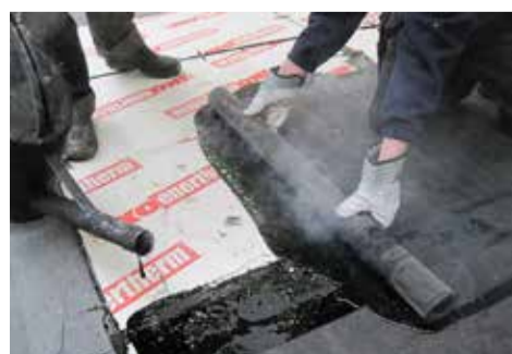
De eerste laag wordt vol en zat gegoten.
