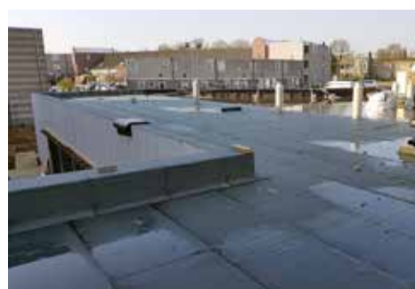
Het compactdaksysteem in opbouw.
