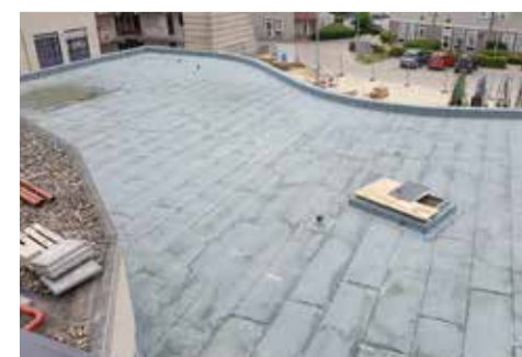
Het compactdaksysteem is afgewerkt met een gemineraliseerde wortelvaste toplaag.
