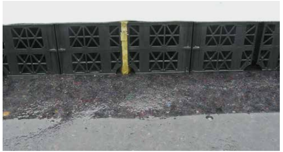
De retentiekragen op scheidingslaag en afgedekt met filterdoek en capillaire cone.
