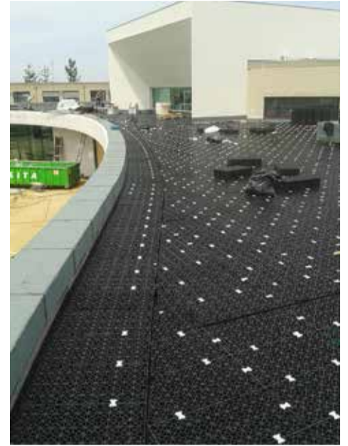
De totale dakoppervlakte is vol gelegd.
