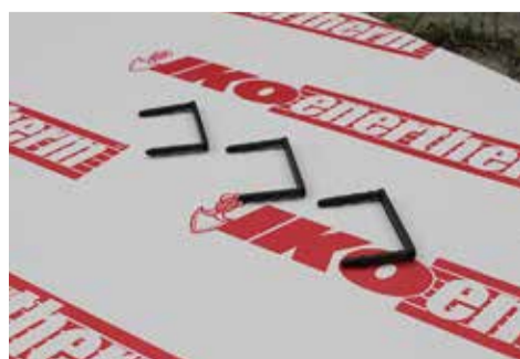
Om verschuiven te voorkomen worden de PIR-platen gekoppeld met kunststof krammen.
