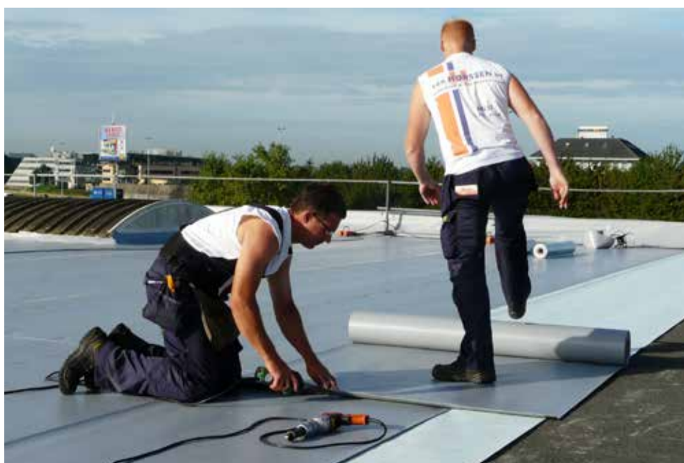
Renovatiwerk in uitvoering
