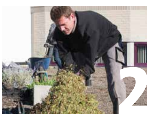
2 IKO roof Compact Retentiedak uitgevoerd door Schiebroek Dakbedekking Dakenraad, Albert van den Hout
